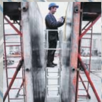
Installation facilitée à l'intérieur des banches.
