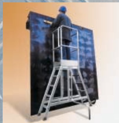
Exemple d'utilisation : travaux de traçage sur banche.
