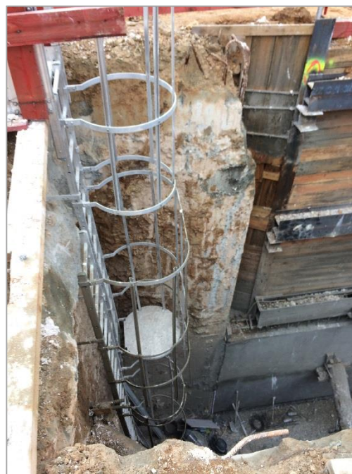
Echelle à crinoline équipée d'un palier escamotable. Version non conforme NF 85 016
