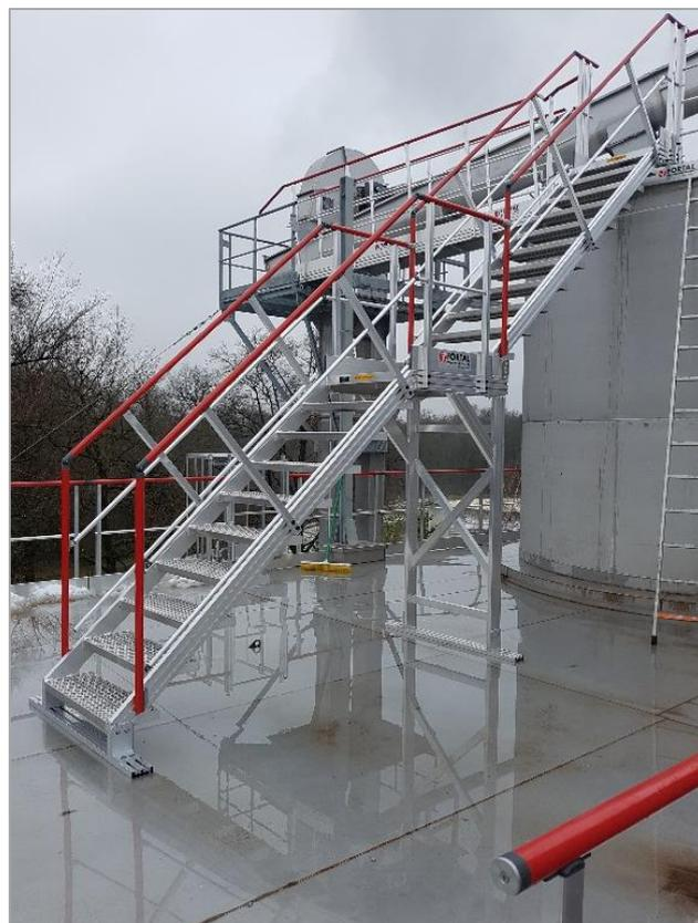
Ci-contre, réalisation d'un escalier à palier – marches caillebotis - pour accès direct sur le dessus d'un silo.
