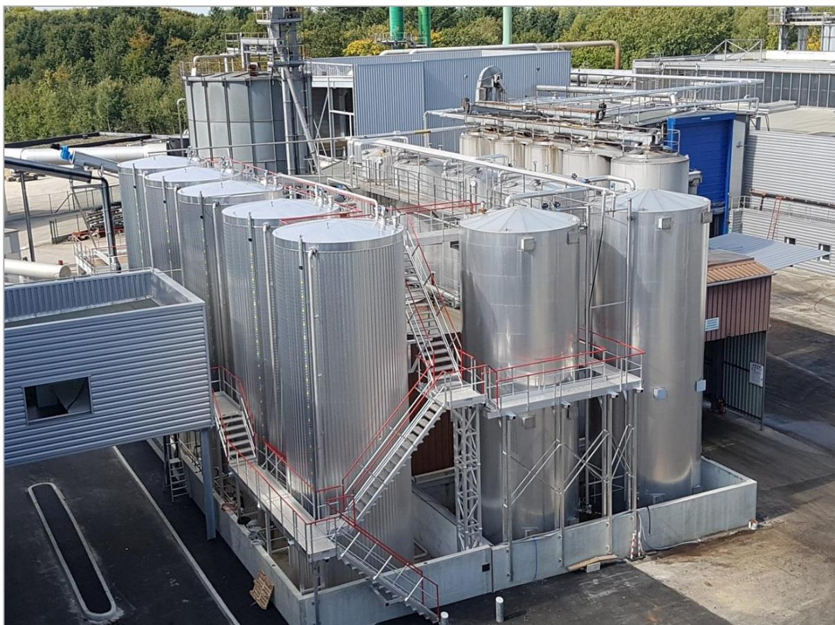
Ensemble de 16 escaliers et de 11 passerelles pour accès et cheminement sur série de silos sur site d'équarrissage, de stockage et de transformation.
