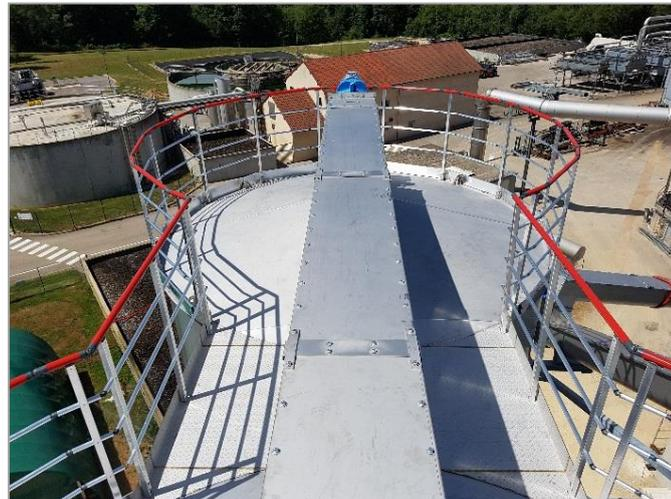
Vues rapprochées sur les garde-corps fixés sur le dessus des différents silos
