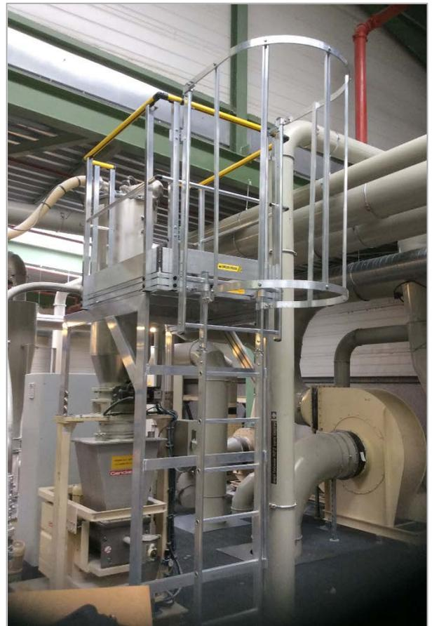
Passerelle d'accès sur poste de contrôle avec échelle à crinoline – hauteur à desservir 2 850 mm – plateforme en tôle alu à damiers 970 x 1 200 mm garde-corps périphérique – portillon – le tout fixé sur poteaux de soutien alu.
