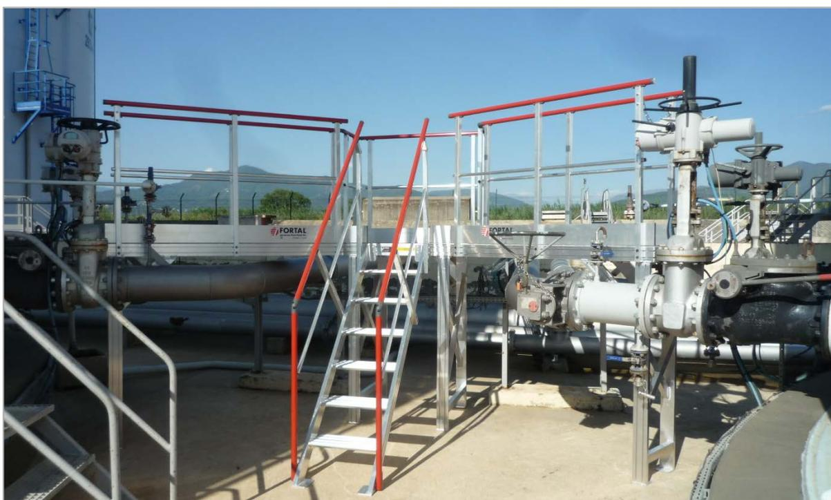
Echelle à marches avec paliers pour passage au-dessus de tuyauteries et accès robinet :
