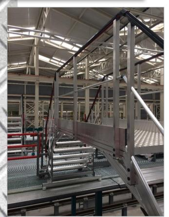
Marches alu antidérapantes prof. 230 mm – largeur du palier : 1 060 mm – revêtement en tôle alu larmée ép. 4.4 mm – garde-corps composé d'une main courante de couleur rouge Ral 3000 – d'une lisse intermédiaire et d'une plinthe.
