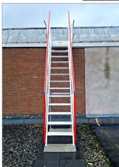
Escalier droit – hauteur à desservir : 2 980 mm – largeur : 600 mm – marches aluminium antidérapantes prof. 261 mm – fixation sur platines – garde-corps laqué rouge RAL 3000 en kit + lisses intermédiaires – fixation au sol par platines sur socles béton.
