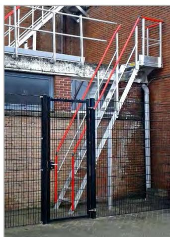
Escalier à plateforme pour accès niveau intermédiaire de la toiture – hauteur à desservir : 3 505 mm – inclinaison : 60°
