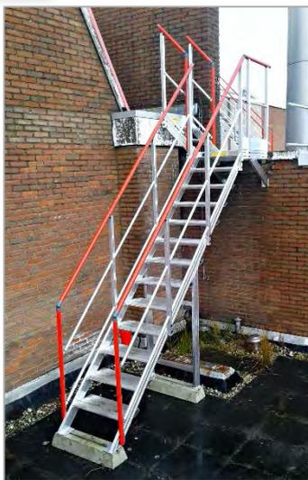
Escalier avec plateforme intermédiaire pour accès depuis 2 points de la toiture au niveau inférieur - hauteur à desservir : 3 230 mm – inclinaison 45° - largeur 600 mm – marches alu striées – plateforme 660 x 800 mm – garde-corps en kit laqué rouge + lisses intermédiaires – fixation au sol par platines sur socles béton.
