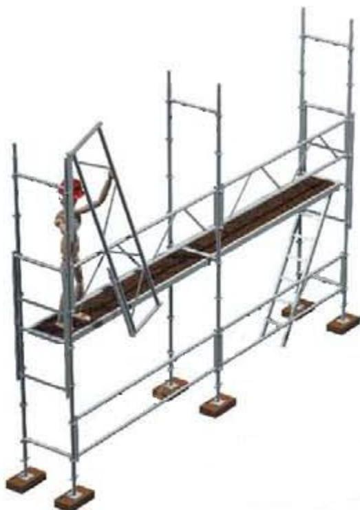
10 Mise en place du 1<sup>er</sup> bras du garde-corps de montage et d'exploitation repliable.
