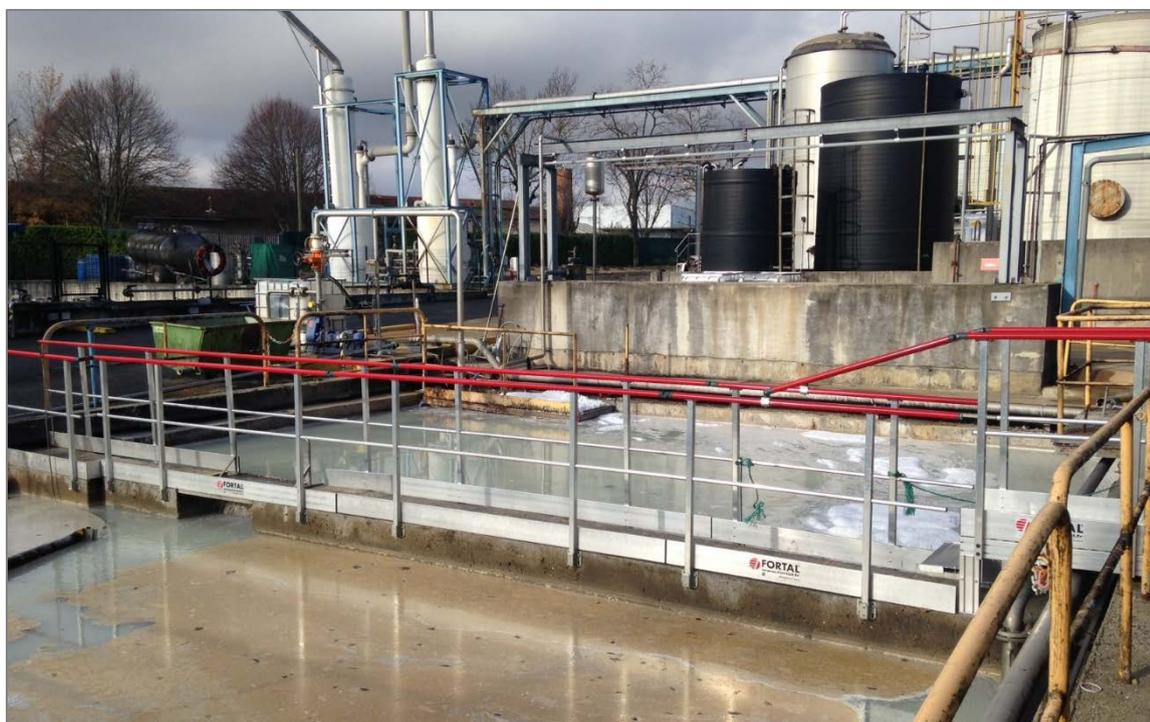
Structure principale en profils aluminium extrudé section 110 x 35 mm installée sur bassin de rétention des eaux usées :
