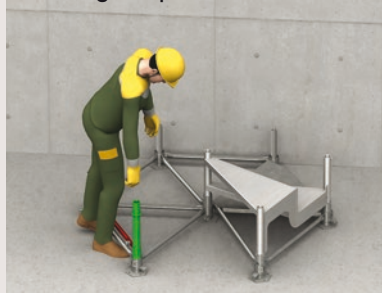
Montage depuis le sol
