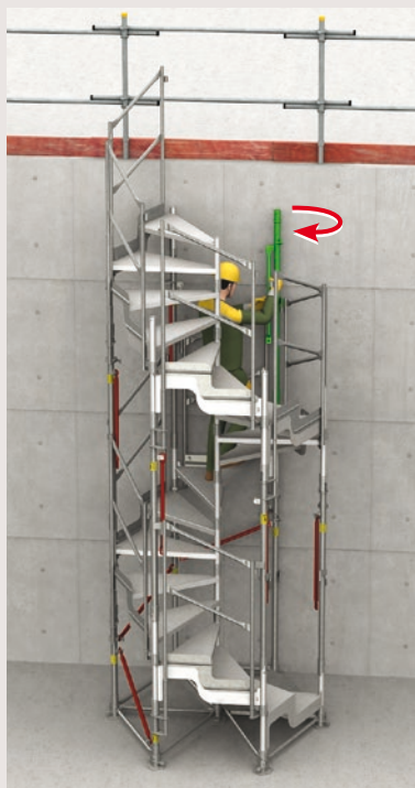
> 8 - Pose d'un poteau ①.
