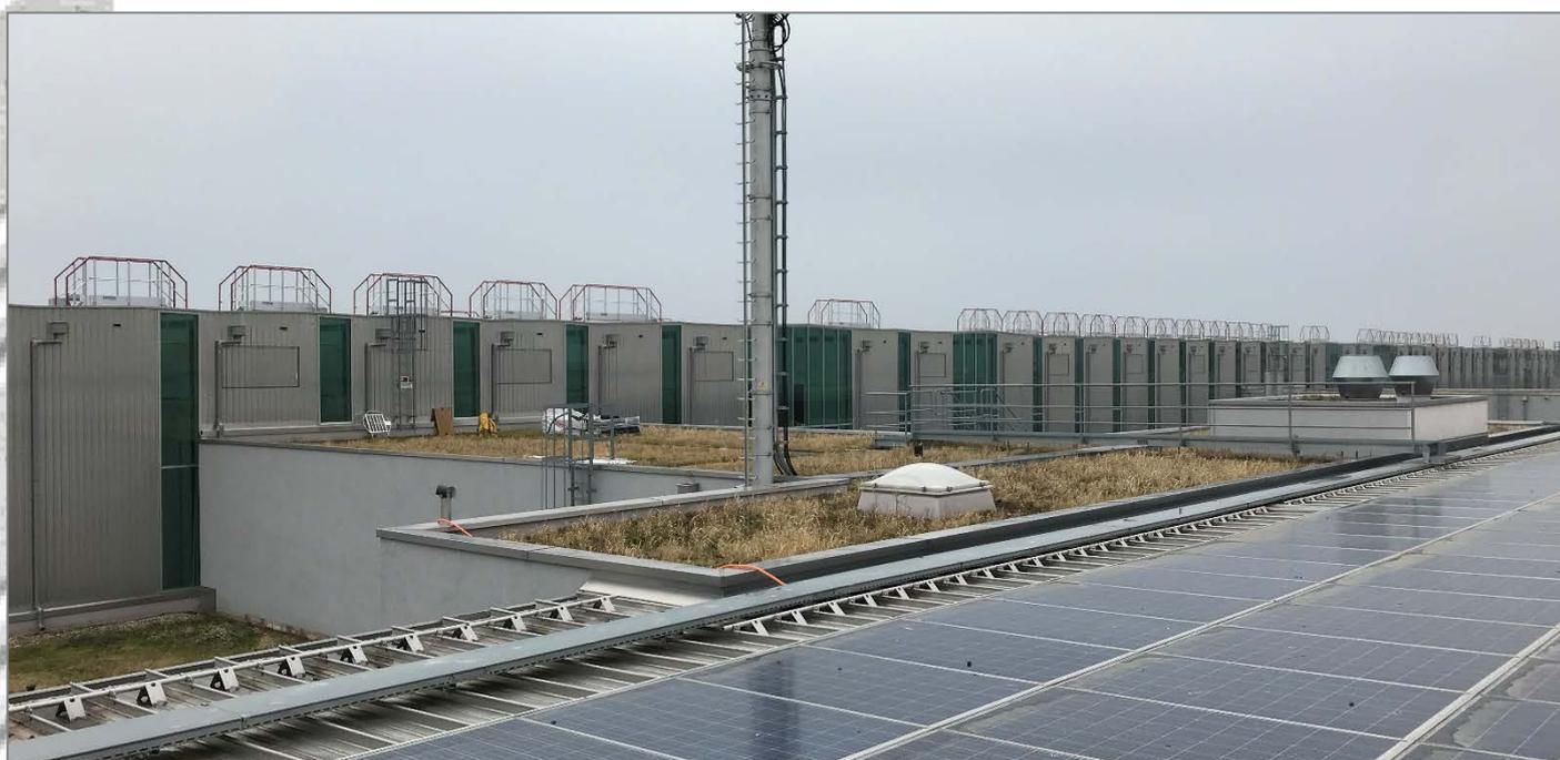
Ensemble de 36 escaliers double accès en profils aluminium brut extrudé 100 x 35 mm pour cheminement sur toiture d'un centre commercial
