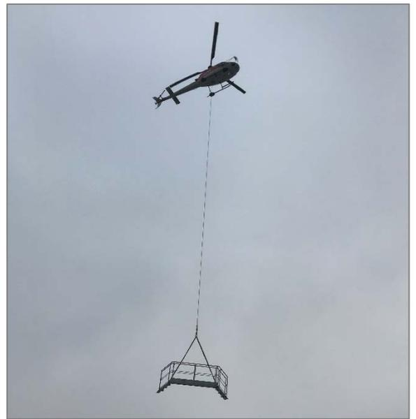
Chaque escalier est équipé d'anneaux de levage, ce qui a permis leur mise en place en toiture à l'aide d'un hélicoptère
