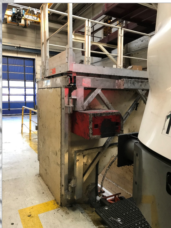
Solution existante avant l'intervention de FORTAL
