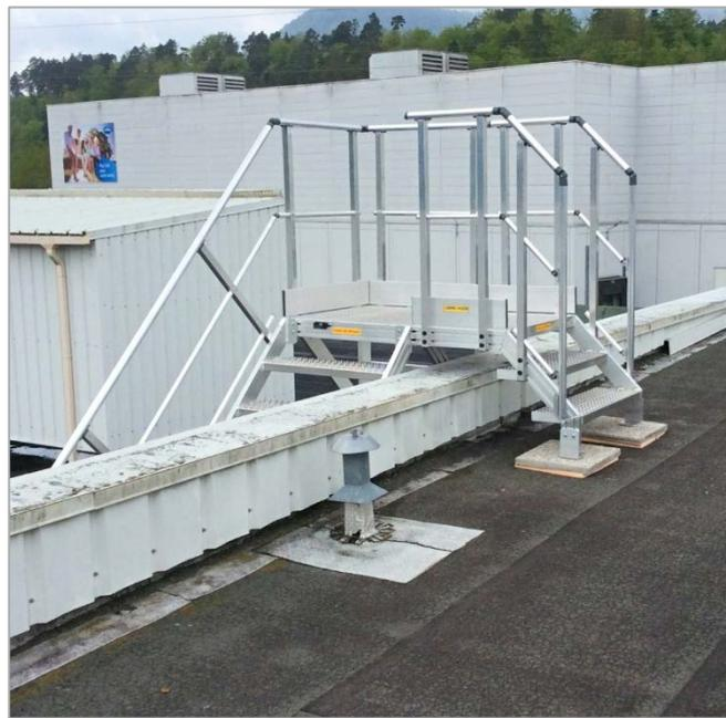
Accès en toiture terrasse composé de 2 escaliers à palier en aluminium brut extrudé 100 x 30 mm
