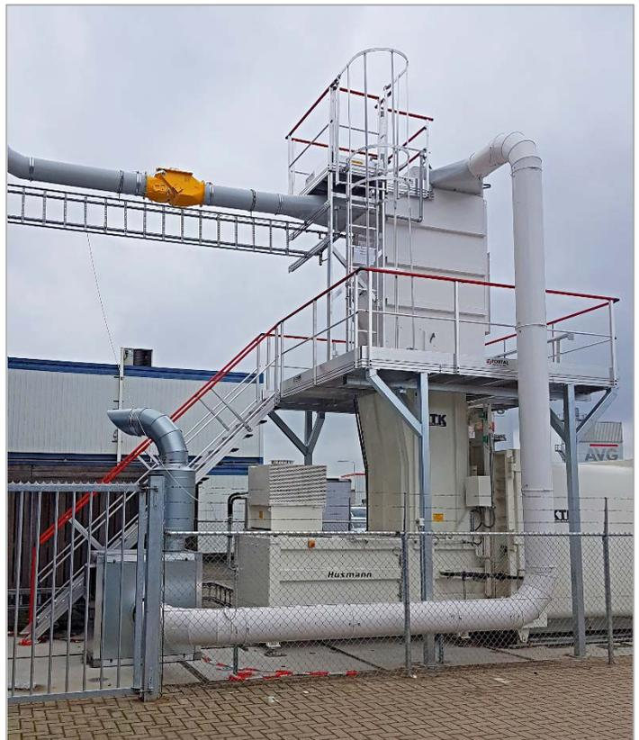
Accès à la passerelle supérieure par échelle à crinoline hauteur 2 800 mm avec portillon
