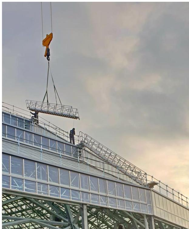
Fourniture clé en main d'un ensemble de trois escaliers en aluminium pour le dôme du zoo de Beauval accessibles via des échelles à crinoline. Douze échelles de redescente dans les gouttières complètent cette réalisation.
