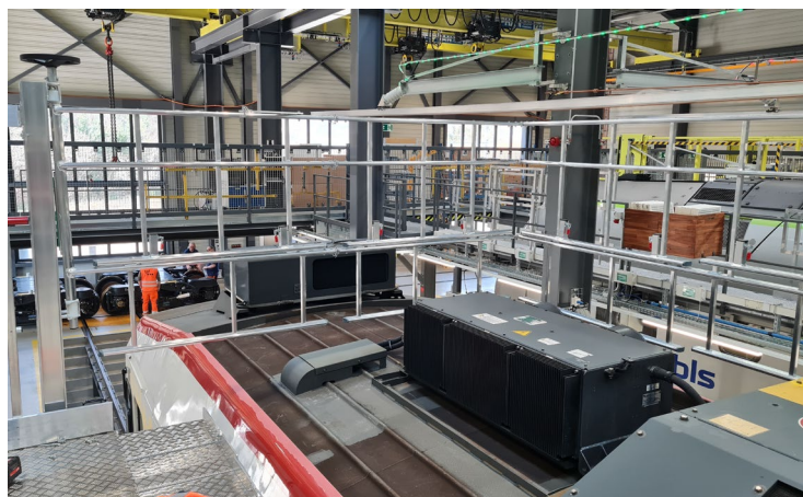
Garde-corps déployé sur la toiture
