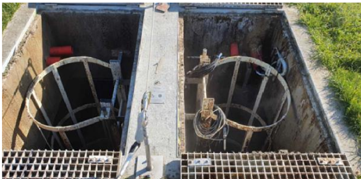
Avant intervention de FORTAL
