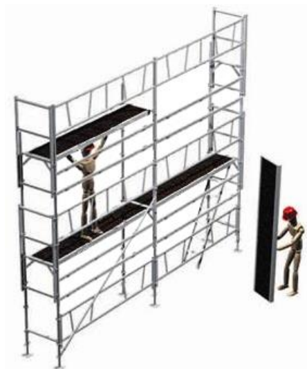
11 - Mise en place des planchers standard depuis le niveau N pour niveau N+1 et finir par un plancher à trappe avec échelle pour la maille d'accès
