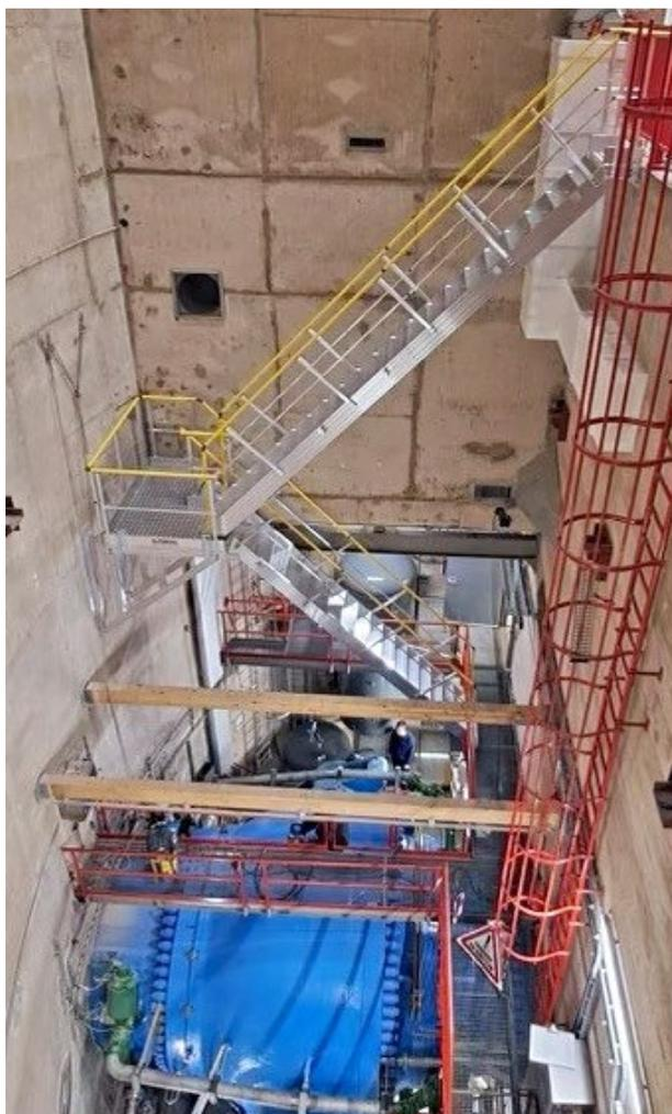
Escaliers avec palier intermédiaire en profil aluminium brut extrudé 100 x 30 mm pour évacuation d'urgence de la zone turbine – hauteur totale de 9250 mm. Alliage d'aluminium série 6000 offrant une haute résistance à la corrosion et ne nécessitant aucun entretien.
