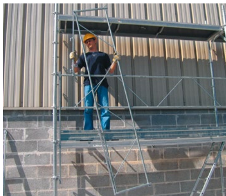
Déverrouillage et déploiement du 1 er bras articulé
