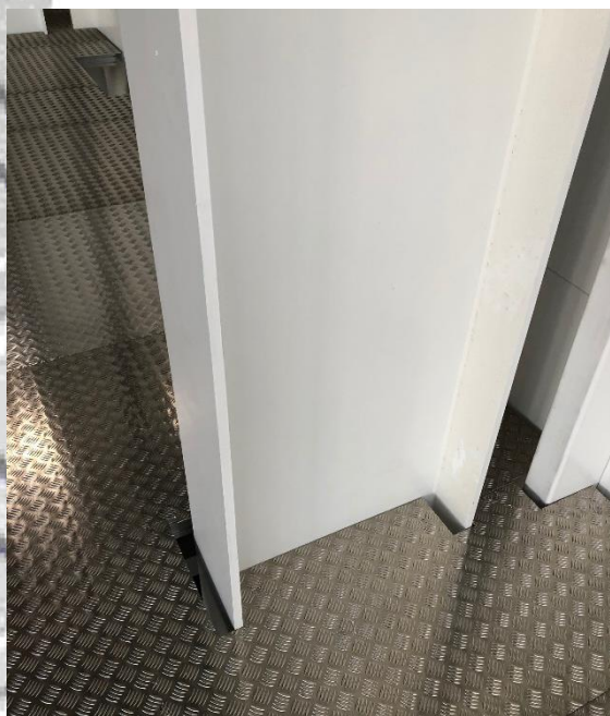
Perfekter Zuschnitt des Aluminiumblechs bei der Montage durch das Montageteam.
