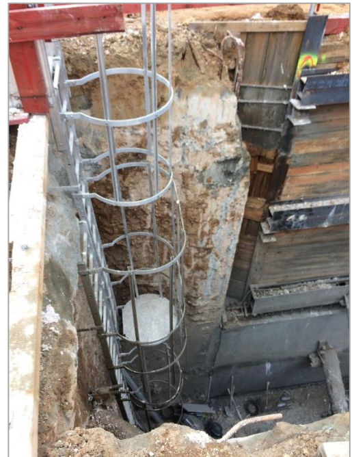
Sicherheitsleiter, die mit einem einklappbaren Podest ausgestattet ist.
