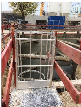
Jede Treppe ist im oberen Teil mit einem Tor ausgestattet
