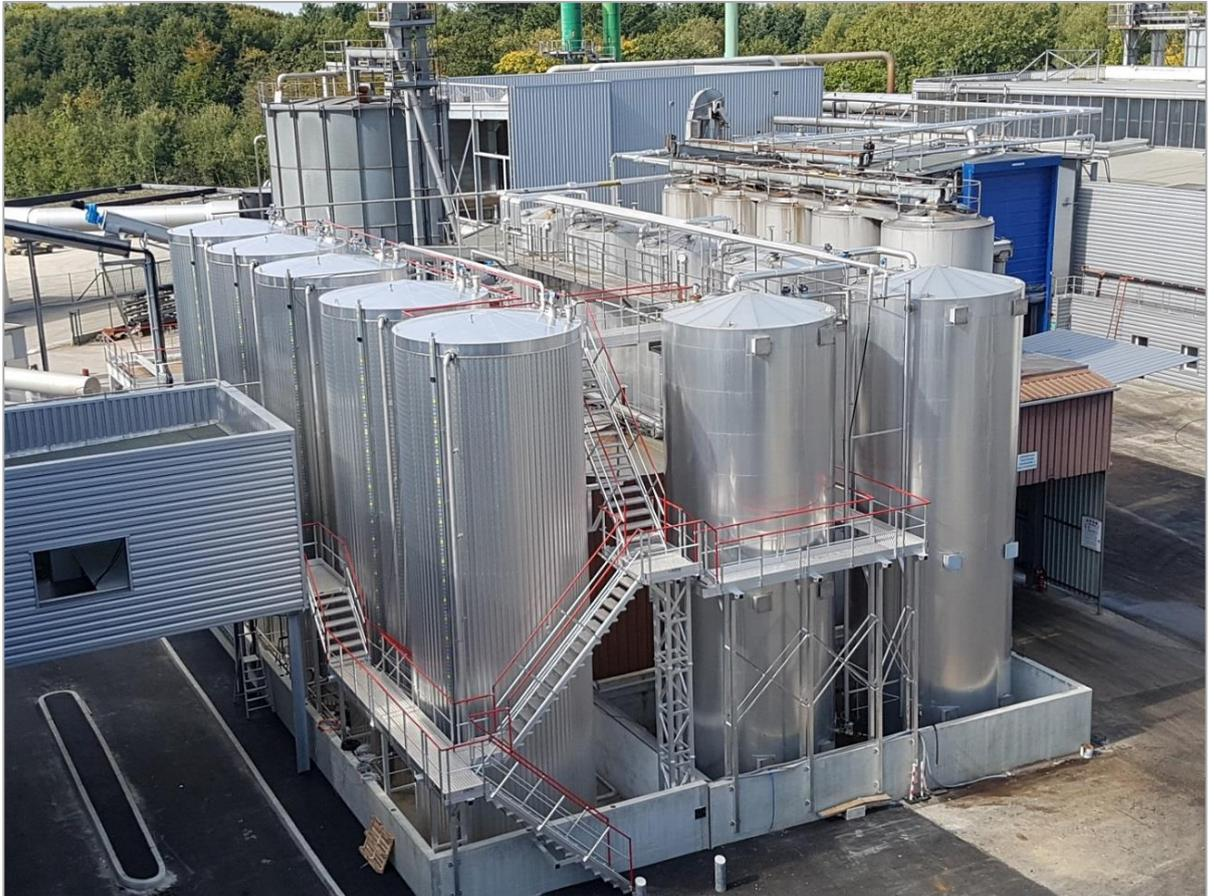
Satz von 16 Treppen und 11 Laufstegen für den Zugang und die Wegführung auf einer Reihe von Silos auf einem Tierkörperverwertungs-, Lager- und Verarbeitungsgelände. Hauptstruktur aus 100 x 30 mm großen Aluminium-Strangpressprofilen. Maximal zulässige Belastung: 200 kg/m<sup>2</sup>.
