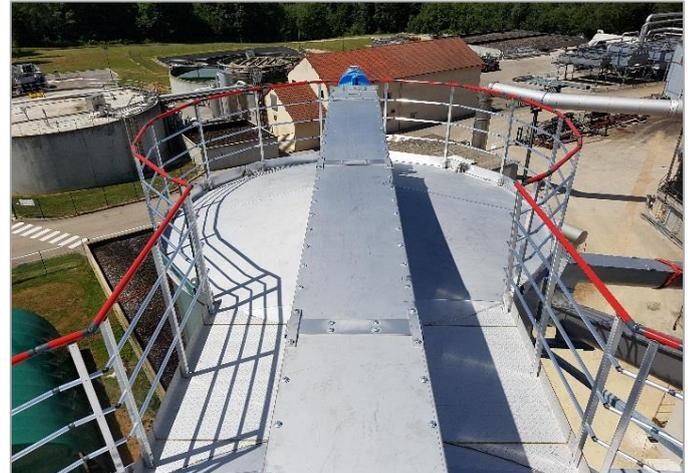
Nahaufnahmen der an den Oberseiten der verschiedenen Silos befestigten Geländer
