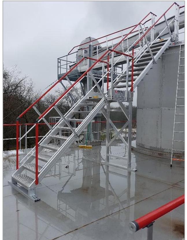
Nebenstehend die Realisierung einer Treppe mit einer Plattform - Gitterroststufen - für den direkten Zugang zur Oberseite eines Silos.
