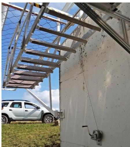
Die Treppe besteht aus zwei Teilen. Der untere Teil der Treppe kann mit Hilfe einer Handwinde angehoben werden, um den Verkehr von Fahrzeugen zu ermöglichen. Die oberste Treppe und der Treppenabsatz sind fix.
