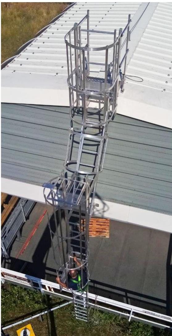
Sicherheitssteigleiter für den Dachzugang zu einer Gondelbahnstation. Aufgrund der Form der Infrastruktur besteht die Leiter aus drei Teilen.
