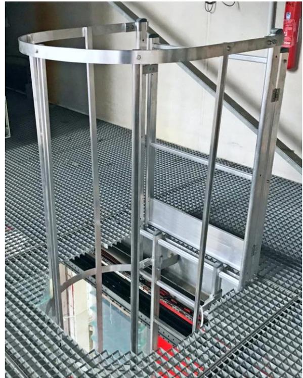
Sicherheitssteigleiter aus Aluminiumprofilen 65 x 25 mm für den Zugang zum oberen Stockwerk.
