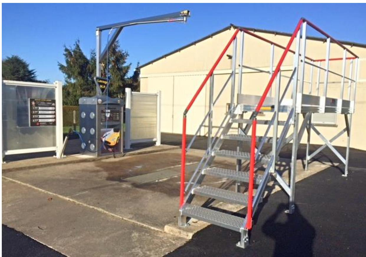
Fixe Plattform aus Aluminium Strangpressprofil 100 x 30 mm für Supermarkt Waschstation.
