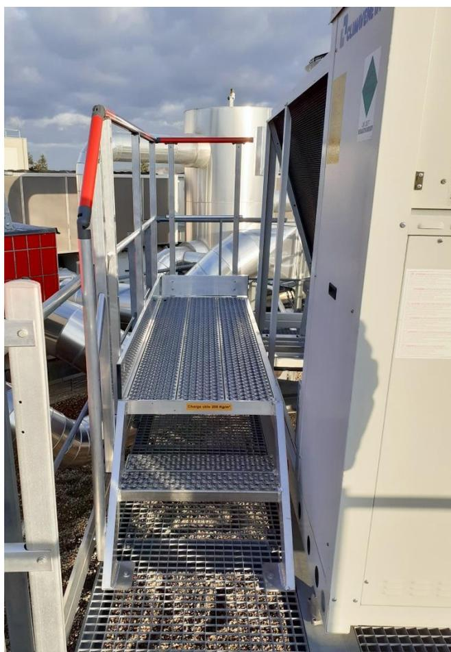
Treppe mit Plattform für sicheren Zugang zur Kühleinheit.
