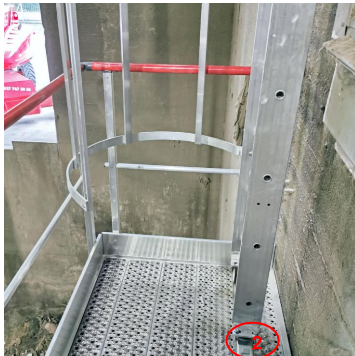
Ansicht des Unterteils der « mobilen » Sicherheitssteigleiter
