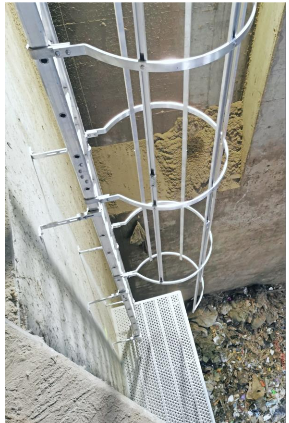
Installation der Sicherheitssteigleiter, die einen sicheren Zugang zum Laufsteg von oben ermöglicht - Höhe: 5.700 mm – front Ausgang oben mit Übergang und Tür
