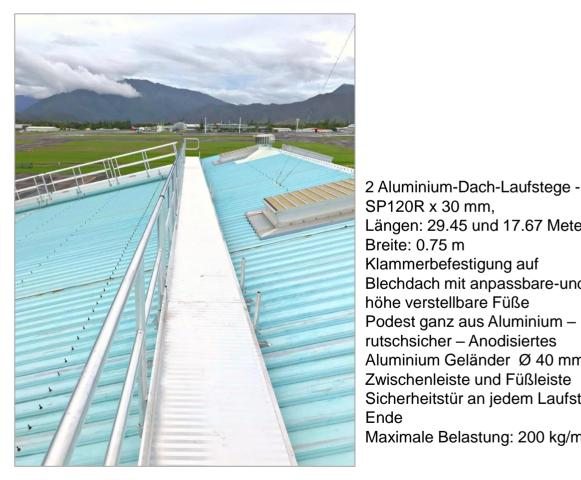
SP120R x 30 mm, Längen: 29.45 und 17.67 Meter -Breite: 0.75 m Klammerbefestigung auf Blechdach mit anpassbare-und in höhe verstellbare Füße Podest ganz aus Aluminium rutschsicher – Anodisiertes Aluminium Geländer Ø 40 mm – Zwischenleiste und Füßleiste Sicherheitstür an jedem Laufsteg
