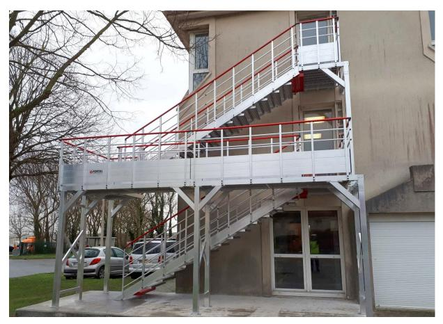
Struktur bestehend aus zwei Treppen und einem Laufsteg, die den Zugang zu den Büros ermöglicht - ERT-Standard (Einrichtungen, die Arbeitnehmer empfangen).
