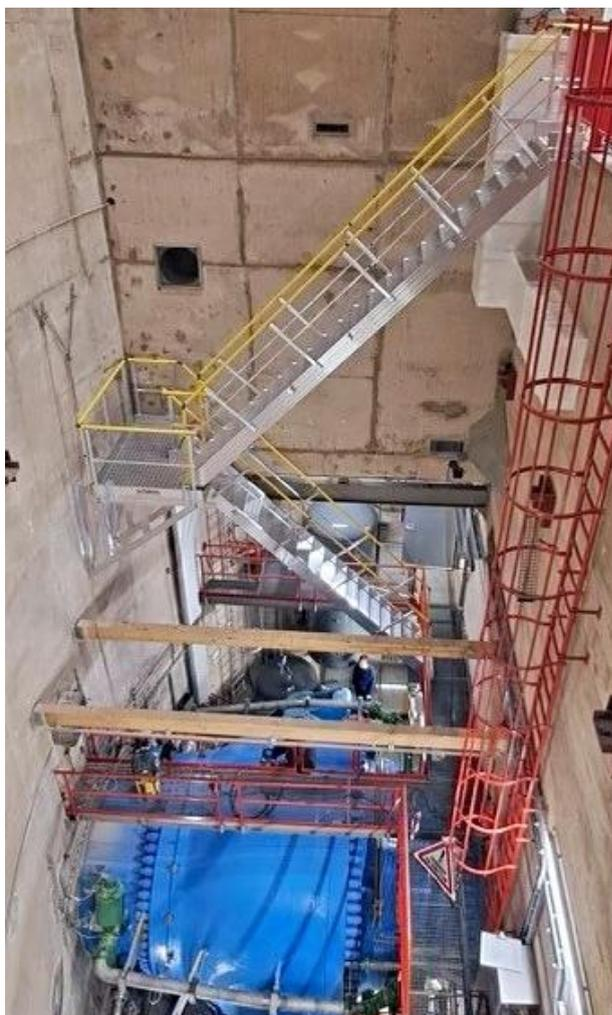
Treppen mit Zwischenpodest aus stranggepresstem rohem Aluminiumprofil 100 x 30 mm für die Notfalleвакуierung des Turbinenbereichs - Gesamthöhe 9 250 mm. Aluminium-Legierung der Serie 6000 bietet hohe Korrosionsbeständigkeit und ist wartungsfrei.
