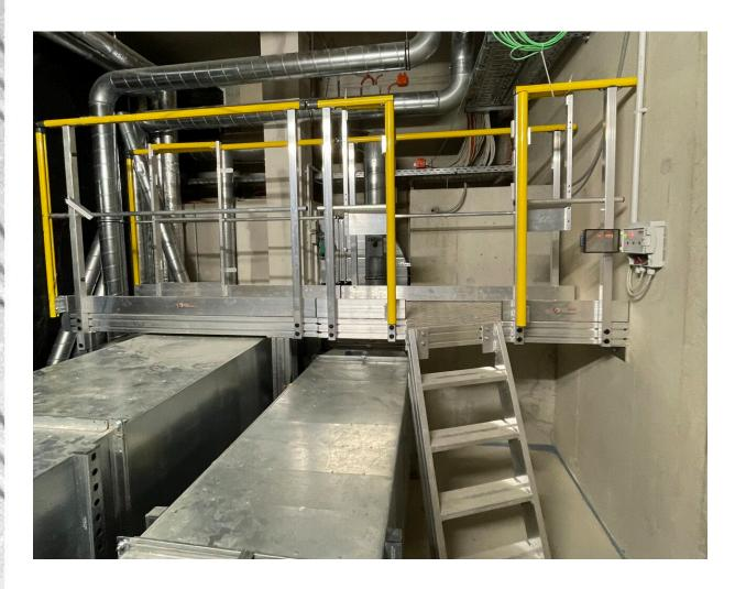
Das Ganze entspricht der Norm EN 85-015. Maximale Belastbarkeit von 200 Kg/m².
