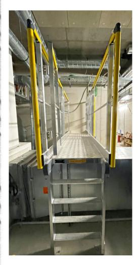
Laufsteg aus stranggepresstem Roh-Aluminiumprofil 100 x 30 mm Serie 6000, der einen sicheren Bedienerverkehr ermöglicht.
