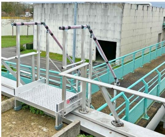
Treppe aus stranggepresstem Rohaluminium 100 x 30 mm Serie 6000 - ermöglicht den sicheren Zugang zum Dach.
