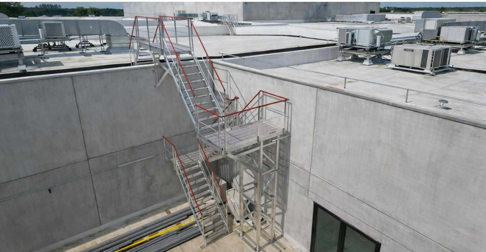
Entwicklung und Fertigung einer maßgeschneiderten Dachzugangstreppe, bestehend aus mehreren Treppenläufen und Zwischenpodesten, einschließlich eines speziellen Podests zum sicheren Überstieg der Attika. Diese Lösung ermöglicht einen sicheren, ergonomischen und langlebigen Zugang zu den Dachbereichen und fügt sich harmonisch in die Architektur des Gebäudes ein.
